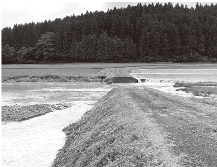
農道が決壊し、水と土砂が流れ込んだ農地
